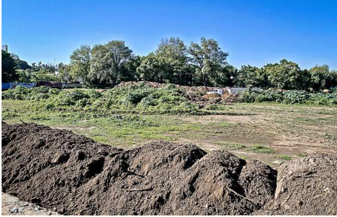
El permiso de construcción para el terreno, ubicado sobre Avenida López Mateos, cerca de la Glorieta Colón, está a nombre de Banca Mifel. Aún se desconoce el número de pisos que tendrá la edificación.
