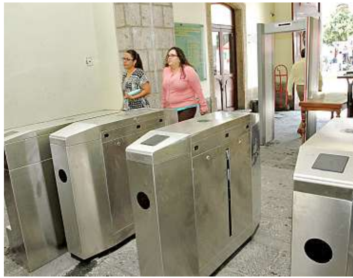
■ Torniquetes para registro de entrada y salida del recinto están siendo instalados en la entrada principal del Poder Judicial.
