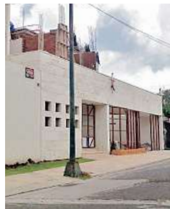
La residencia de Plascencia está en construcción.
